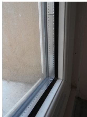
Figura 2.3 - Particolare dei serramenti – dettaglio angolo vetro
